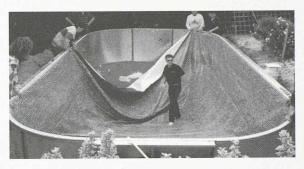
dèles à choix). La forte résistance des panneaux permet de remblayer le pourtour extérieur même si la piscine est vide ou, inversément, de la remplir avant remblayage.
