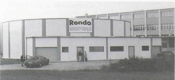
Expériences novatrices sur le chantier du parking d'Oberbüren: une construction ronde et, à la place du béton armé, un squelette en acier pour les futurs box où emmagasiner les véhicules
