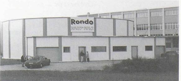
Expériences novatrices sur le chantier du parking d'Oberbüren: une construction ronde et, à la place du béton armé, un squelette en acier pour les futurs box où emmagasiner les véhicules
