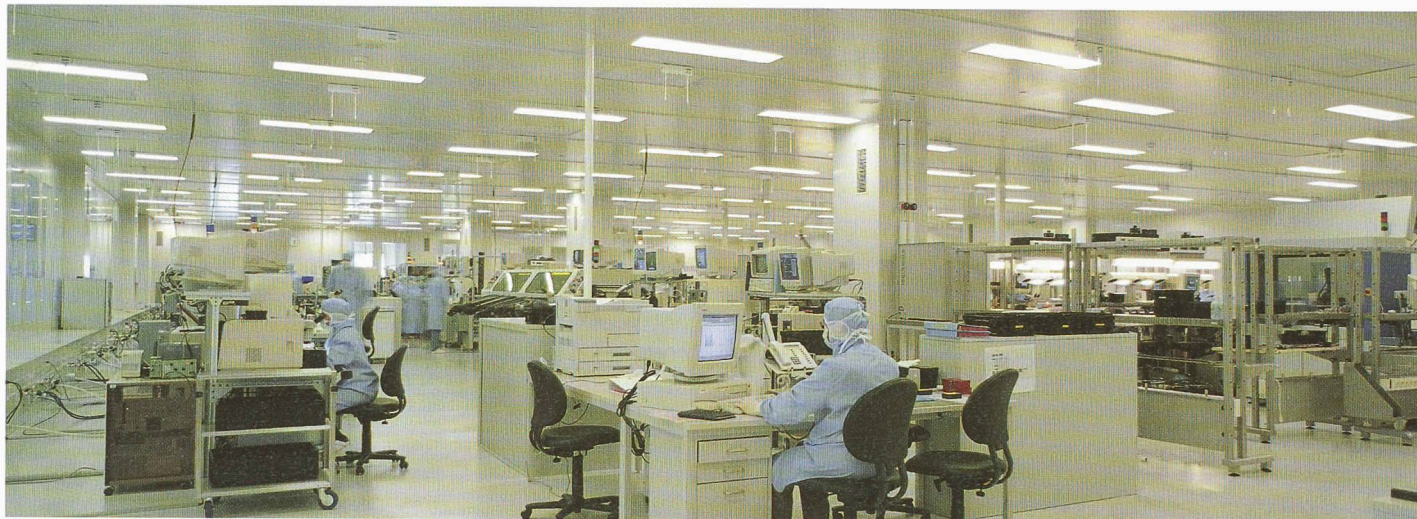
La salle blanche répond, en phase de production, à une classe de propreté 100000 (10000 pour une zone restreinte)
