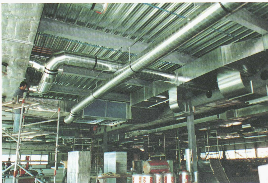
Pose des installations techniques dans le plafond de la salle blanche (photo Luwa)
