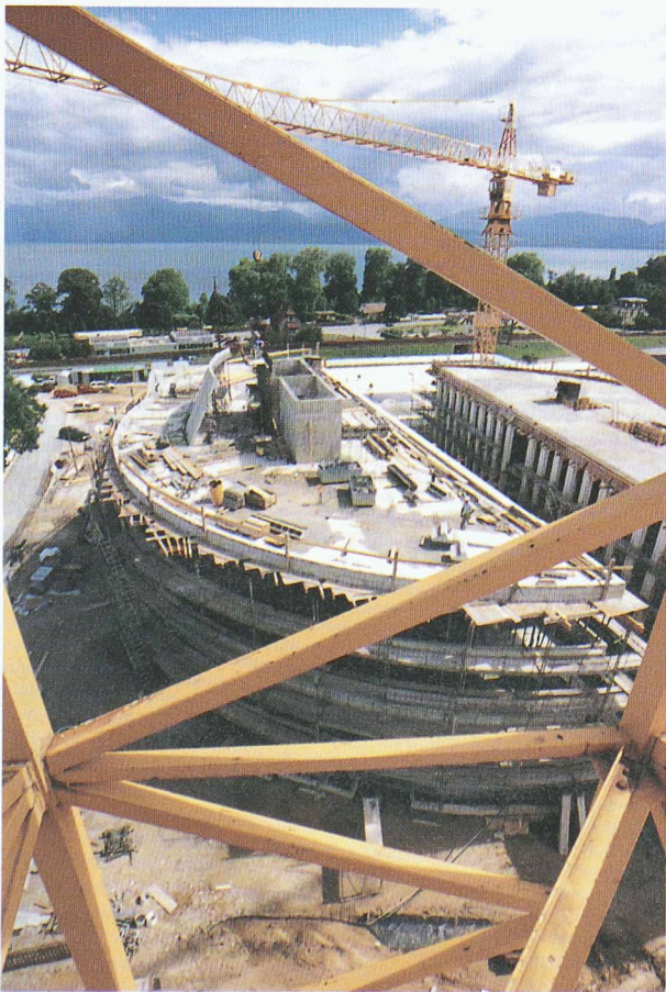
Vue partielle du chantier
