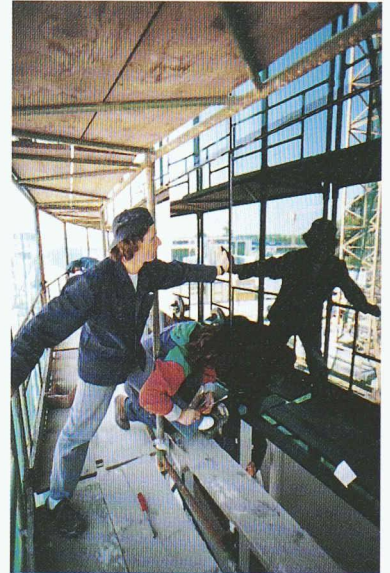
Pose des façades vitrées; pas moins de septante corps de métier ont été appelés à collaborer.
