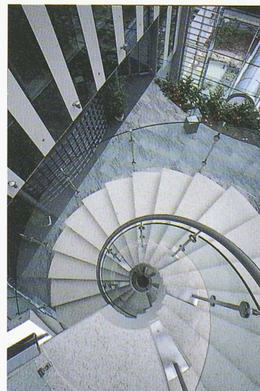
L'escalier reliant les différents niveaux du bâtiment administratif
