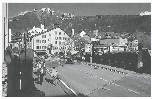
Fig. 9. – Nouveau pont sur la Saltine: en cas de crue, le torrent fournira désormais lui-même l'énergie nécessaire pour soulever automatiquement l'ouvrage afin d'éviter qu'il ne constitue un obstacle à son passage.
