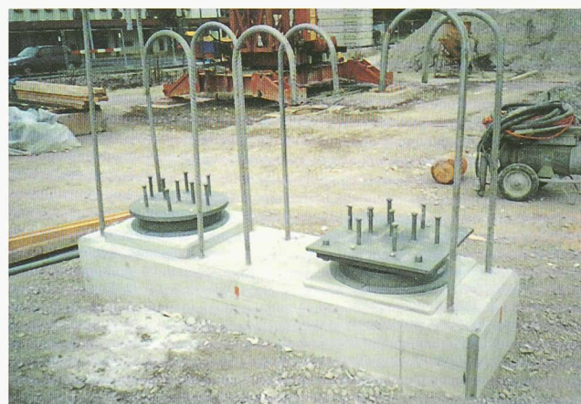
Pont de raccordement à la Voie-Centrale: socle avec appuis pots et barres servant d'encastrement provisoire
