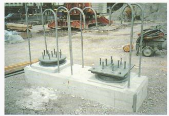
Pont de raccordement à la Voie-Centrale: socle avec appuis pots et barres servant d'encastrement provisoire
