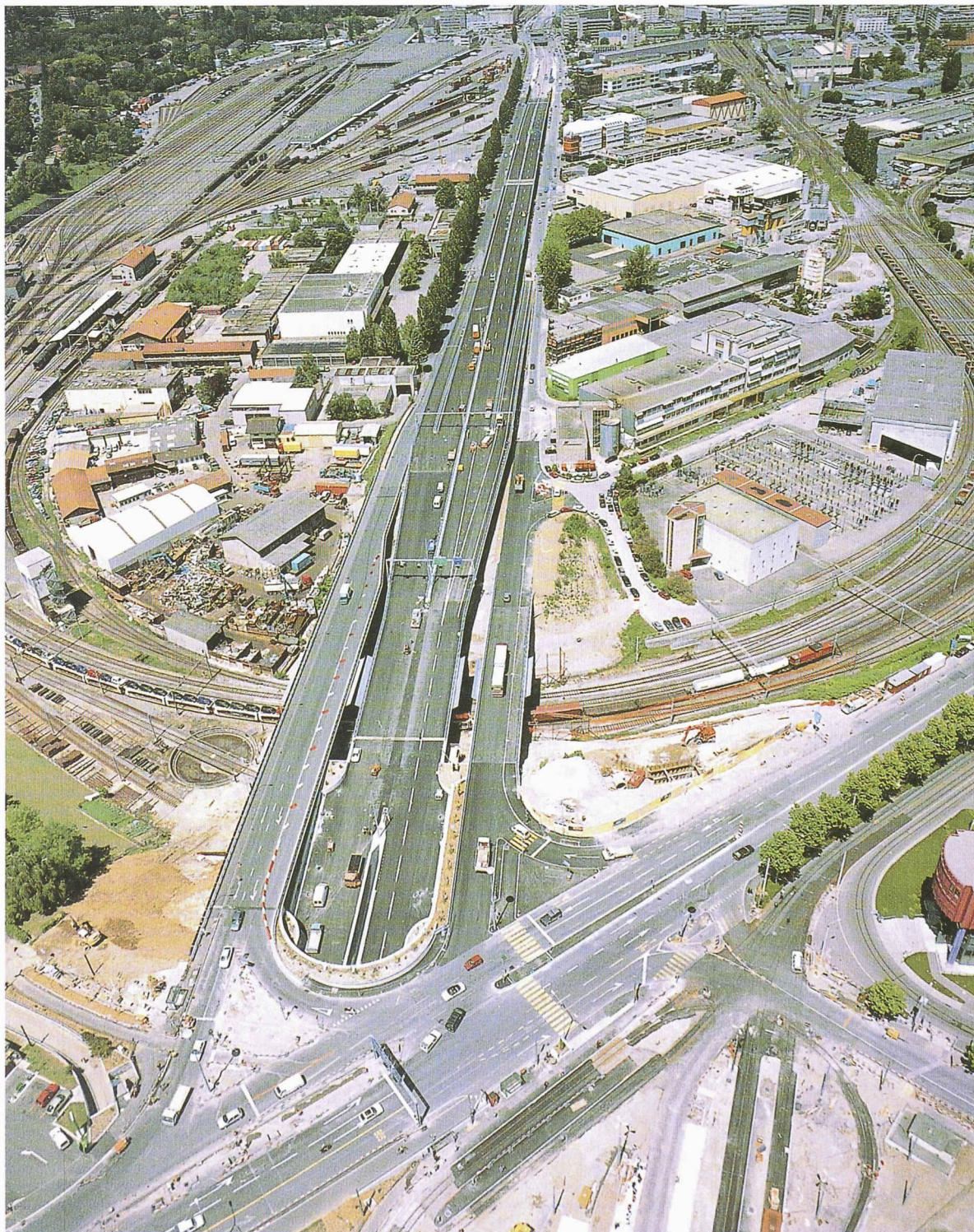
Débouchant de la tranchée couverte du Bachet-de-Pesay, l'autoroute est raccordée par un pont à la Voie-Centrale, un ouvrage surélevé qui a dû être adapté. Les deux ponts latéraux rétablissent la continuité des circulations locales en surface.
