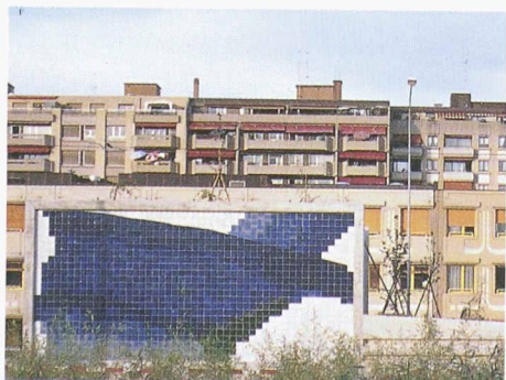
Les portails d'accès de la tranchée couverte des Palettes, de forme cubique, offrent une protection contre le bruit. Les plans inclinés qui les prolongent sont aménagés en «jardins suspendus» alors que leurs faces latérales sont revêtues d'émaux de grès colorés avec des terres naturelles. Chaque accès a une couleur dominante. (Photos: Mathias Thomann)
