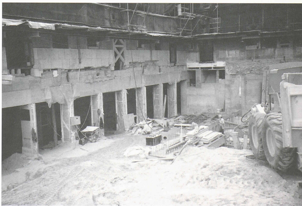
Travaux de reprise en sous-œuvre
