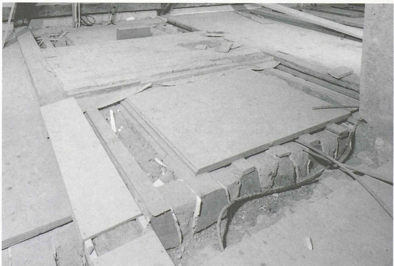
Combles: renforcement des planchers
