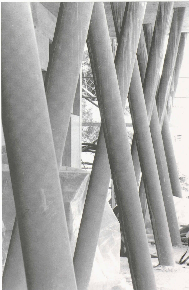
Structure porteuse, rez-de-chaussée
