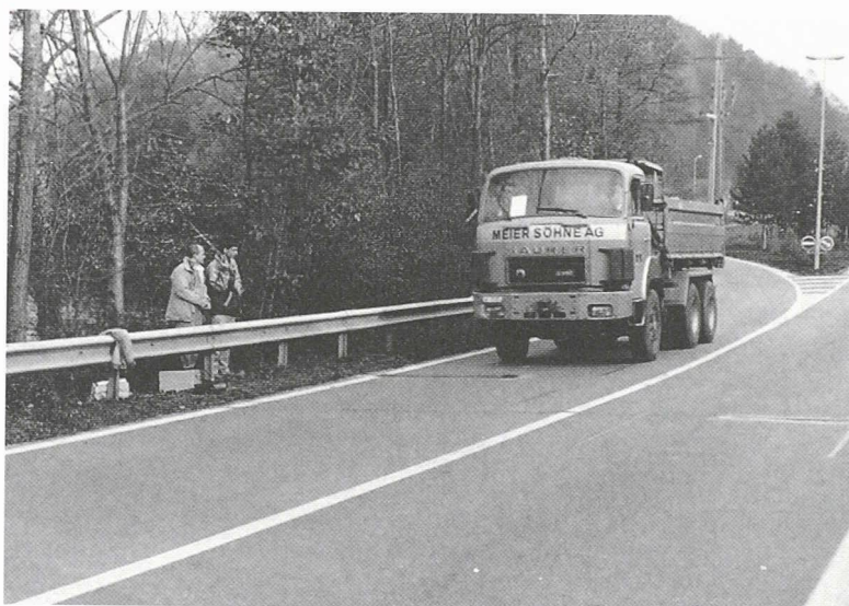
Fig. 1. - Camion passant sur l'installation de mesure des véhicules en marche
