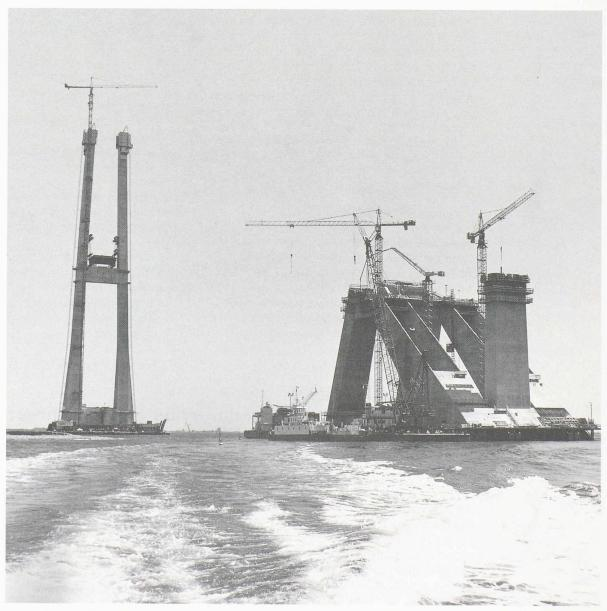
Fig. 7. - Pont de l'Est: pylône et bloc d'ancrage
