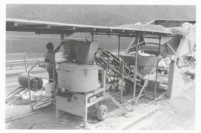
Fig. 4. - Installation de bétonnage sur le chantier
