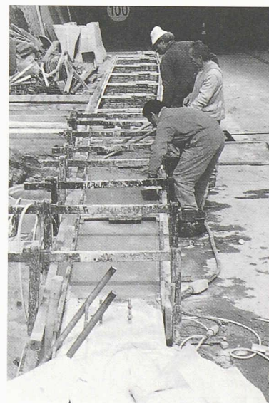
Fig. 5. - Mise en œuvre du mortier
