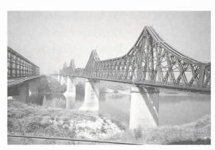
A droite: le pont d'A. Saligny. A gauche: le nouveau pont combiné rail-route (2 voies au milieu + 1 piste routière sur console de chaque côté), en service depuis 1987.
