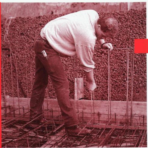
NOUVEAU TYPE S avec section de ferraillage As = 754 mm<sup>2</sup>/m<sup>1</sup>
