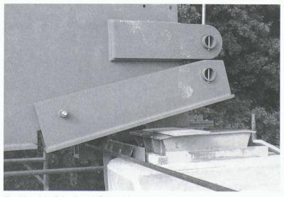
Fig. 10. – Détail du dispositif de guidage
