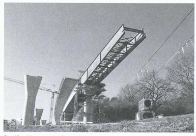
Fig. 12. – Vue montrant l'avant-bec
