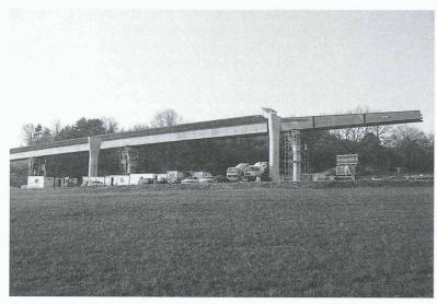
Fig. 11. – L'ouvrage en cours de lancement
