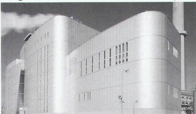
Hoesch isowand integral® est un système complet pour bardage à fixations cachées. Ce système répond aux exigences élevées requises par les architectes et les planificateurs concernant les propriétés constructives, l'isolation thermique et la résistance aux intempéries, sans pour autant négliger l'esthétique.
