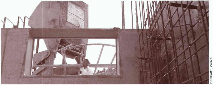
Le nouvel intrados ACO MARKANT®, posé par Spleiss Bauunternehmung AG, projet: construction Rütihof à Zurich
