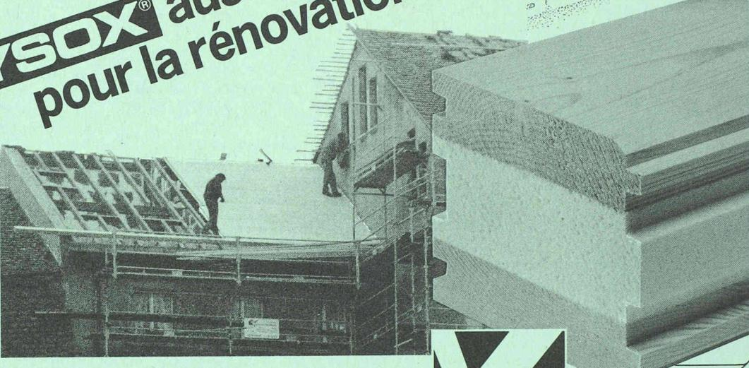
Le madrier isolant YSOX pour la rénovation de vos toitures, éléments
