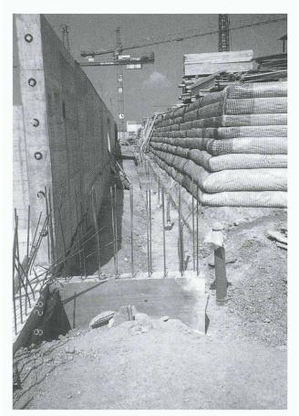
Fig. 3. - Stabilisation du terrain par micropieux et par géoarille: vue du chantier
