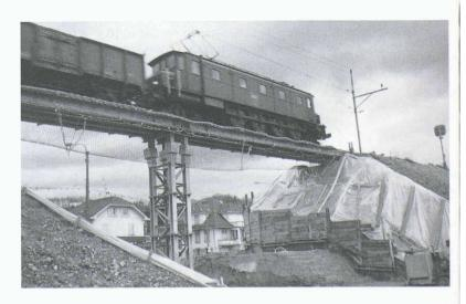
Fig. 7. – Structure provisoire sous la charge d'un train de marchandise: deux ponts métalliques reposant sur une pile centrale
