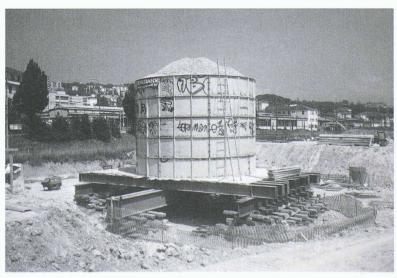
Fig. 4. – Essai de charge des pieux sous un poids de 300 t
