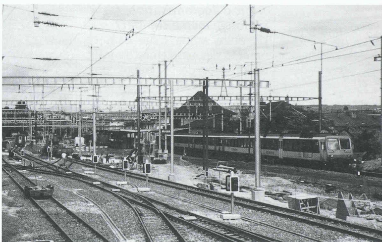
Début de Rail 2000 en Suisse romande: le réaménagement de la gare de Morges
