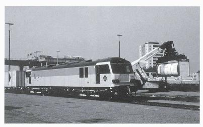
La Grande-Bretagne au bout des rails: ici l'une des 46 nouvelles locomotives électriques bicourant (750 V continu en Angleterre, 25 kV/50 Hz dans le tunnel) de la classe 92, acquises pour le trafic Transmanche (dont 7 pour les trains voyageurs de nuit). L'équipement électrique est fourni par ABB, la partie mécanique par Brush Traction Ltd, Loughborough, et Prorail, Wakefield.
