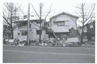
Fig. 14. – Maison en bois ayant basculé sur la gauche sous l'effet de soft-storey
