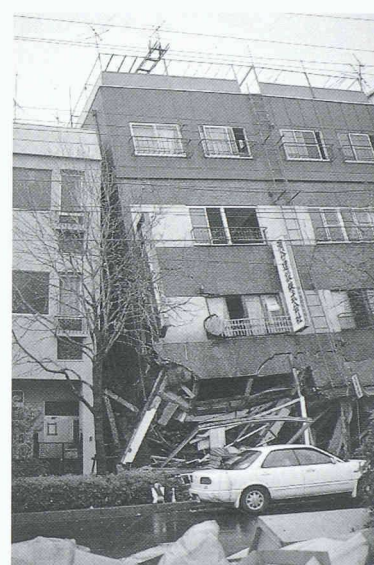
Fig. 18. – Ancien bâtiment endommagé, incliné contre un bâtiment récent intact
