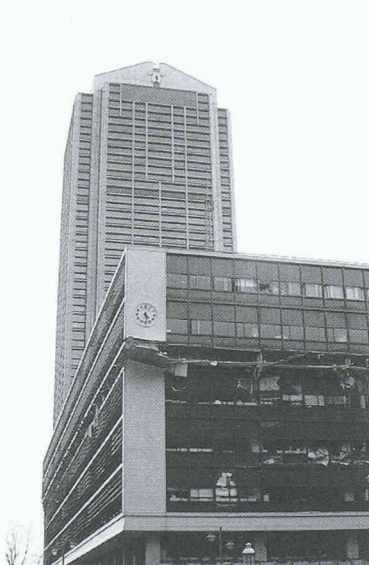
Fig. 15. – Bâtiment de l'administration communale avec un étage intermédiaire effondré
