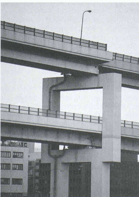
Fig. 12. - Porteur du pont supérieur sur le point de tomber
