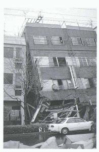
Fig. 18. – Ancien bâtiment endommagé, incliné contre un bâtiment récent intact
