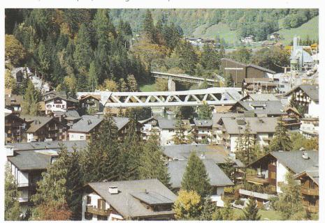
Les portiques situés aux extrémi- 101 tés de l'ouvrage sont des cadres massifs devant absorber d'importants efforts de torsion et ils sont, de surcroît, inclinés. Leur armature et la disposition des câbles de précontrainte ont donc requis une attention particulière.
