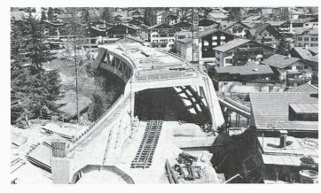
Fig. 14. – Le nouveau pont, avant et après son ripage sur une distance de 10 m
