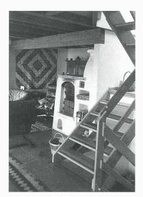
Fig. 2 – Villa familiale à Chardonne: l'emploi du poêle installé par le propriétaire offre un grand confort et permet de couvrir 30% des besoins en énergie de chauffage. (Photo: C. Mercier)
