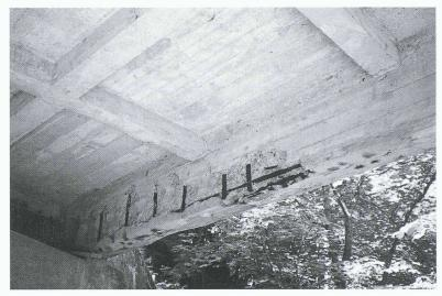
Fig. 3. – Armature rongée, réparation partielle
