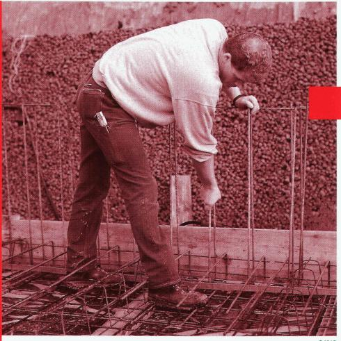
NOUVEAU TYPE S avec section de ferraillag As = 754 mm²/m¹
