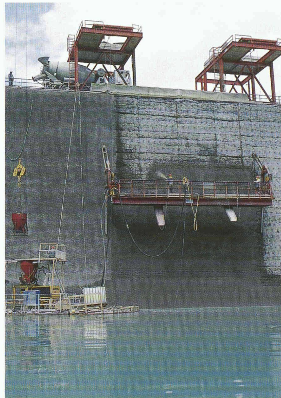
Fig. 10. - Equipement nécessaire à la projection du béton: pompe sur radeau, plate-forme de travail, portiques de suspension de la plate-forme, benne à béton, camion malaxeur
