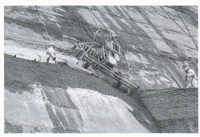
Fig. 5. – Robot d'hydrodémolition. La tringle de guidage de la lance est bien visible.
