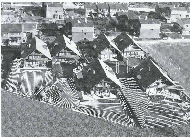
Cette colonie de 6 maisons individuelles à Worblaufen (Berne) est chauffée depuis 10 ans de façon fiable et écologique par 6 pompes à chaleur (dont on voit les collecteurs souterrains).
