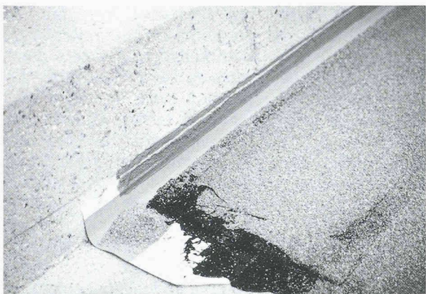
Fig. 5. - Raccord 4: le joint en PVC est fixé à la bordure en béton avec du mortier époxy et collé au LBP par du bitume polymère.
