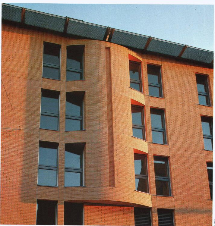
Avant-garde technique pour la réalisation de façades préfabriquées en brique de parement en terre cuite.
