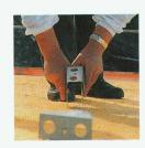
Une simple vis autoforante, passant par le trou supérieur du TAFIXE, permet de fixer à la visseuse et sans pré-perçage les contre-lattes aux chevrons. Le second trou sert à des raccords solides entre contre-lattes.
