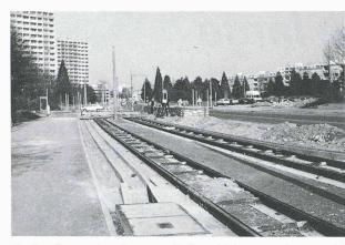
Fig. 8. — Construction d'une nouvelle ligne. Ici, la route existante a été déplacée pour l'aménagement du site propre du futur tramway.
