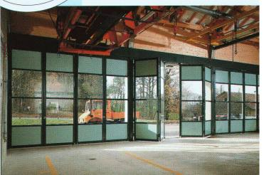
Solutions techniques personnalisées: passage de lignes de contact par rupteur de câble pivotant. Porte entièrement vitrée en vitrage isolant doubleface et protection solaire.
