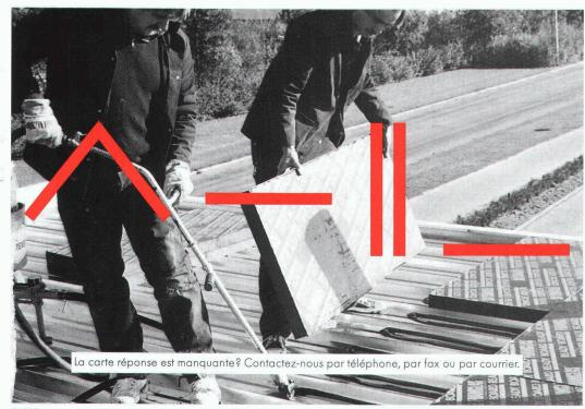
FOAMGLAS®-READY BOARD est un produit spécialement développé par Pittsburgh Corning pour l'isolation des toitures plates ou inclinées avec support bac acier et couverture métallique. (Photo ci-dessus: FOAMGLAS®-READY BOARD collé par stries d'adhésif à froid PC® 11 sur la crête des nervures du bac acier).
