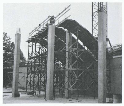
Fig. 8. – Réservoirs de Bernex: coffrage d'une dalle inclinée
