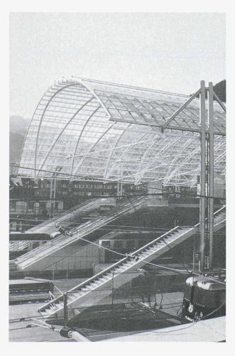
duction avec, en plus, des tolérances minimes dans les dimensions. Le raccordement, par soudure, des pannes aux arcs présente une géométrie variable selon la hauteur de celles-ci et a nécessité le recours à un robot spécialement programmé.
