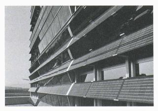
lules puissent être refroidies, car leur rendement diminue avec l'élévation de leur température. Pour cette raison, des systèmes de refroidissement des panneaux ont été mis au point. Certes, la quantité d'énergie thermique récupérée est environ le double de celle de l'énergie électrique produite, mais, comme la chaleur ainsi obtenue n'est que partiellement utilisable, le taux de rendement de l'énergie thermique reste comparable à celle de l'énergie électrique.
