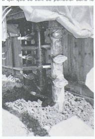
Fig. 3. – Vue des trois tarières sécantes à axes parallèles. L'injection des fluides se fait par le point bas de l'outillage.
