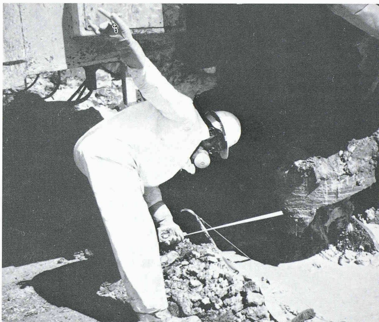
Fig. 4. – Contrôle de l'implantation d'une colonne de traitement par un technicien équipé selon le règlement de sécurité pour ce chantier
