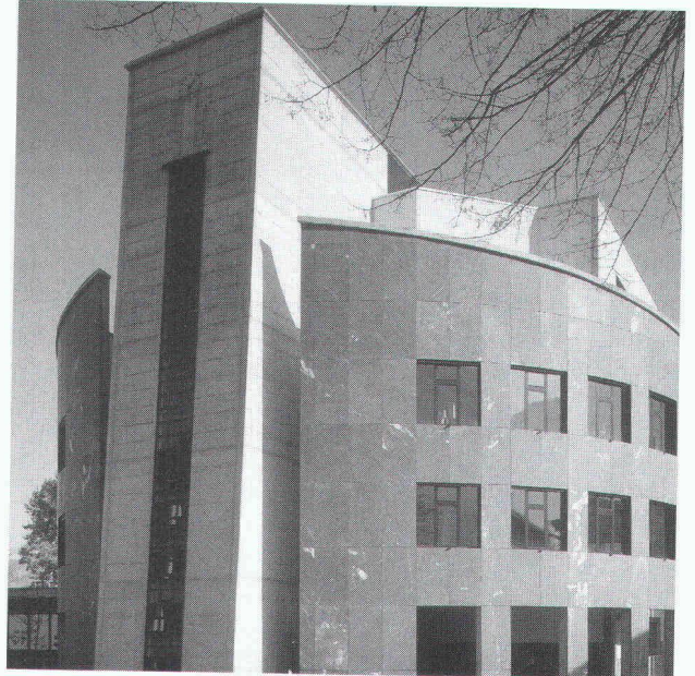
Bâtiment scolaire, Martigny
