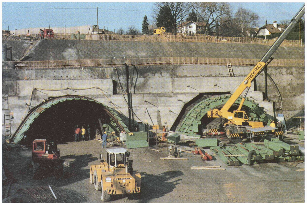
Fig. 7. – Attaques sous boucliers au portail sud
