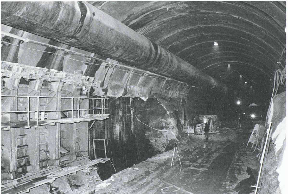
Fig. 10. – Réalisation d'un piédroit
