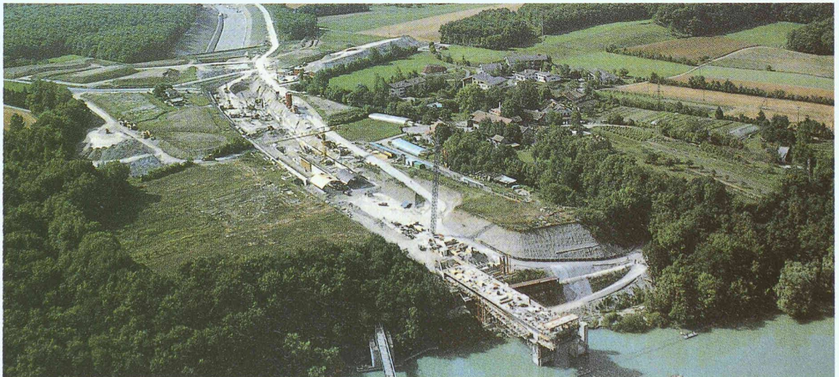
Fig. 3. – Tranchée couverte de Chèvres: photo du chantier avec, au premier plan, le pont d'Aigues-Vertes
