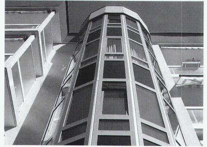
La face extérieure avec le revêtement métallique ventilé garantit une haute résistance aux intempéries et préservation, la face intérieure en bois une atmosphère agréable. Grâce à la simplicité de leur montage, les fenêtres bois/métal constituent une solution optimale pour les transformations et les constructions neuves.
