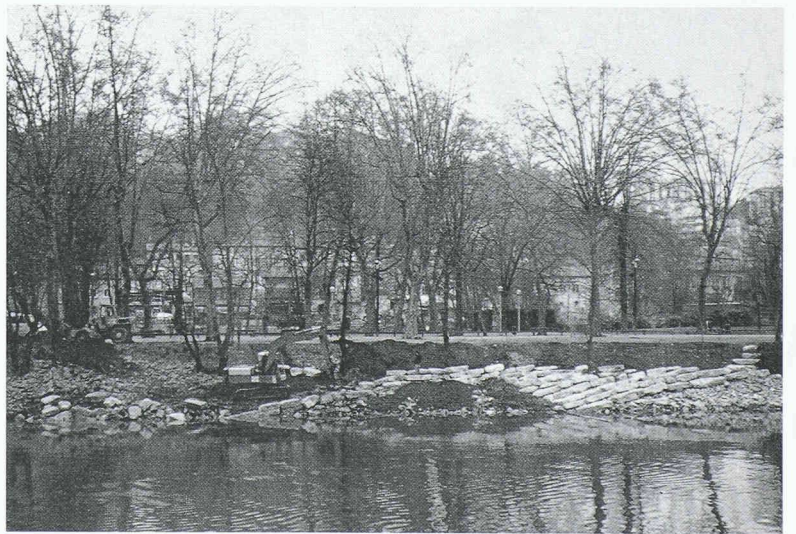
Ile, état existant
