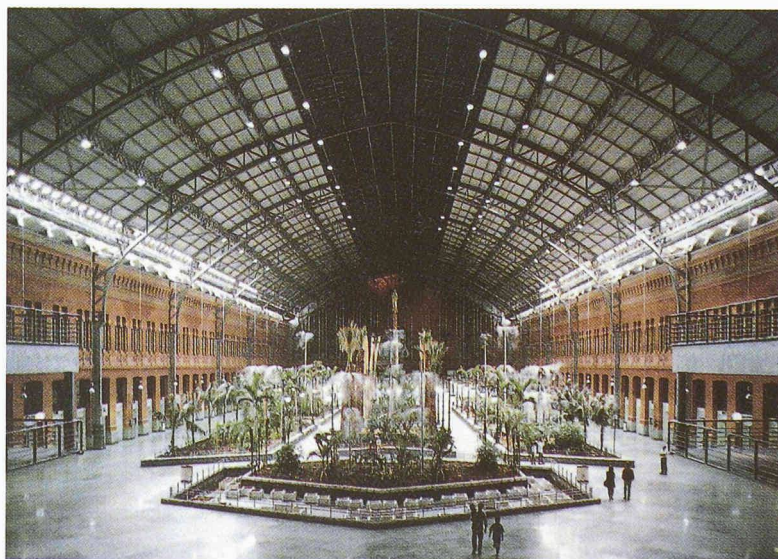
Gare des grandes lignes Atocha, Madrid (mention) – Direction générale de l'infrastructure ferroviaire, Madrid. Mandataire: Rafael Moneo Valles, architecte La remarquable et minutieuse rénovation de l'ancienne toiture vitrée a permis de maintenir en vie un bâtiment qui mérite d'être conservé pour de multiples raisons. Le projet prévoit, entre autres, un jardin tropical qui met en valeur l'espace ainsi ménagé. C'est un nouveau et excellent point de rencontre tant pour les Madrilènes que pour leurs visiteurs, qui a abrité la cérémonie de remise des Brunel Awards 92 ainsi que l'exposition des projets primés.
