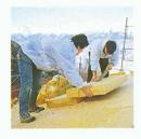
Après traçage, le TAFIXE est enfoncé dans l'isolant en quelques coups de marteau. Sa hauteur correspondant très exactement à l'épaisseur de l'isolant garantit une planimétrie parfaite du toit.
