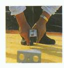
Une simple vis autoforante, passant par le trou supérieur du TAFIXE, permet de fixer à la visseuse et sans pré-perçage les contre-lattes aux chevrons. Le second trou sert à des raccords solides entre contre-lattes.
