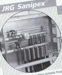
Le système d'installation d'eau potable froide et chaude, qui résiste à la corrosion
