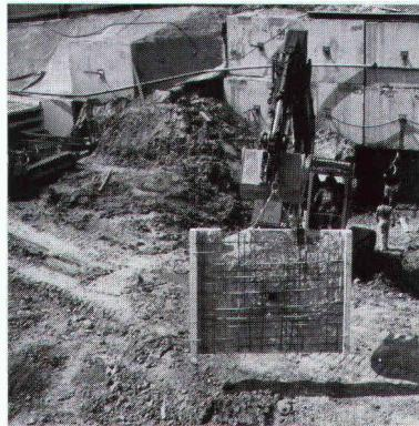
A situation particulière, solution spéciale: pour garantir la sécurité d'une construction scolaire sur un terrain instable, saturé d'eau, c'est à un blindage de fouille, décrit en pages 128 et 129 de ce numéro, qu'ont recouru les ingénieurs.
