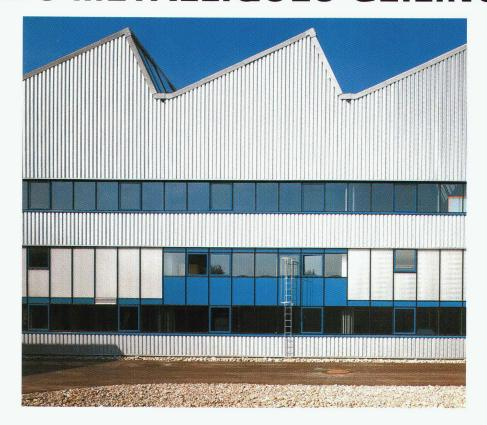
Le système de toitures métalliques en shed Geilinger continue de démontrer son efficacité pour les bâtiments industriels: une technique au point avec des atouts économiques et fonctionnels.
